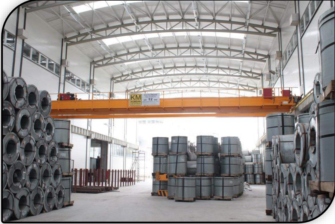
12 Ton Kapasiteli Çift Kirişli Gezer Köprülü Vinç
